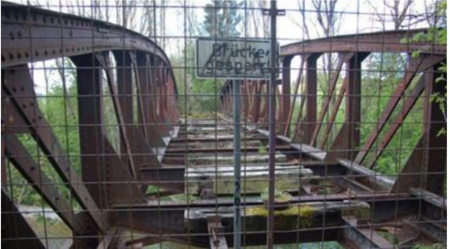
Alte aufgegebene Eisenbahnbrücke über die Untere Argen bei Isny. (Foto: Archiv: Uwe Jauß)
